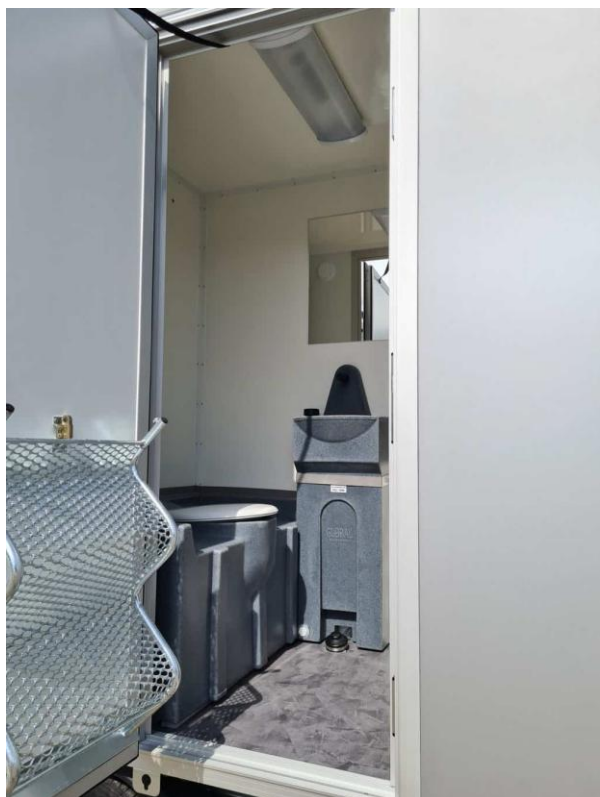
Hvert rom inneholder kjemikalietolett med toalettpapirholder og vask med speil og berøringsfri armatur
